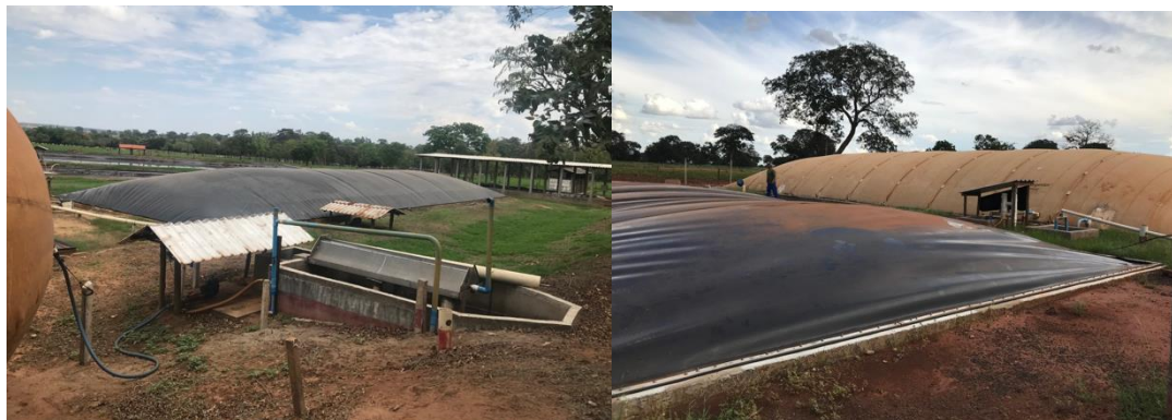
Figura 7 - Biodigestor em operação instalado em propriedade no Estado de Goiás, Região de Rio Verde
